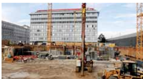
Die Baustelle Praterstern 3
