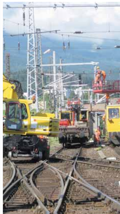
Erneuerung der Fahrleitungen in Villach
