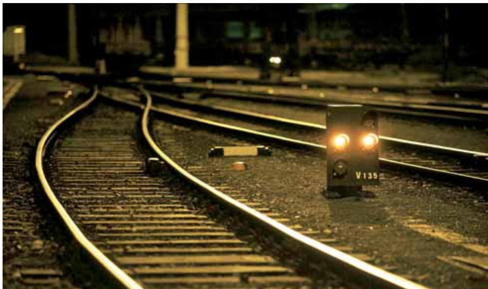
Stellwerk Süßenbrunn macht wieder pünktlichere Züge möglich.
